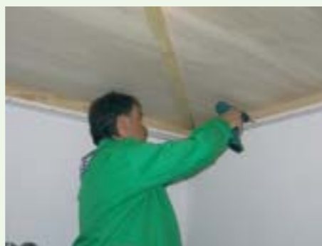
bevestigen van de wandprofielen
