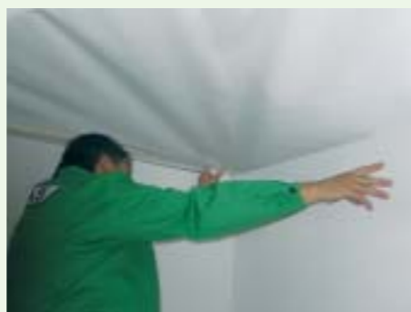
inbouwen van het op maat gemaakte plafond
